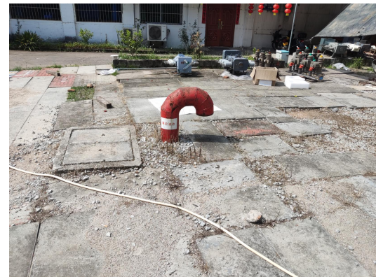
变电站西侧围墙外现状事故油池
