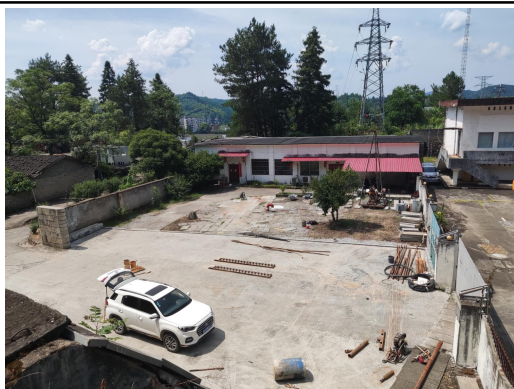
变电站西侧外环境
