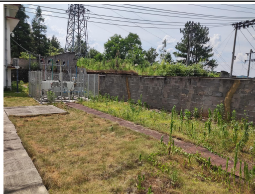
变电站北侧环境
