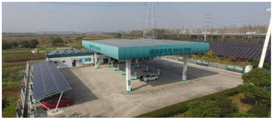
图 4-4 江苏高速路服务区光储充一体化充电站
